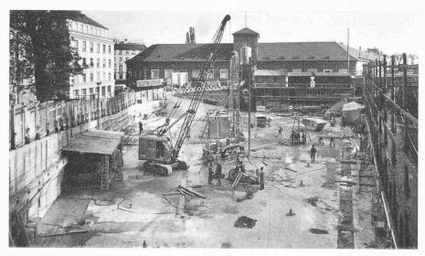
Bild 19. Blick gegen Bahnhof Enge. Umschliessungswand erstellt. Reihen der Entlastungsdrains als Stutzen sichtbar. Seite Gutenbergstrasse (links im Bilde) verankerte Rühlwand
