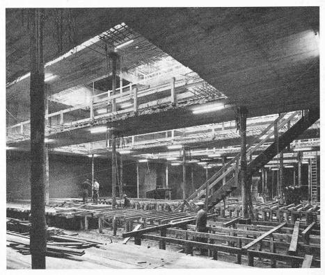
Bild 10. Schalen der Decke über dem vierten Untergeschoss
