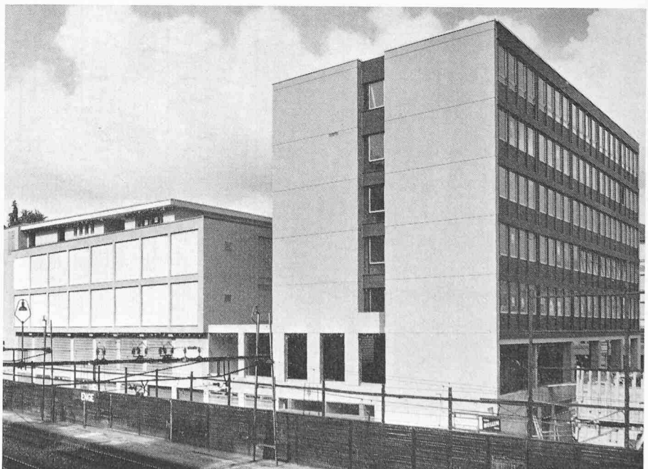
Bild 1. PTT-Betriebsgebäude, Ansicht von der Perronseite
