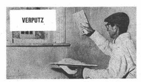
Styrofoam lässt sich ausgezeichnet mit allen gebräuchlichen Materialien verputzen. Pressplatten, Gipstafeln und Täfelungen können direkt darauf angebracht werden. Styrofoam wird mit Zementmörtel unmittelbar auf das Mauerwerk aufgeklebt. Dadurch senkt es Arbeitszeit und Arbeitskosten erheblich.
