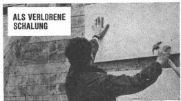
Die hohe Festigkeit von Styrofoam FR erlaubt die Verwendung als Schalung bei dünnschaligen Betonkonstruktionen. Durch seine Oberflächenstruktur verbindet es sich innig mit dem Beton.
