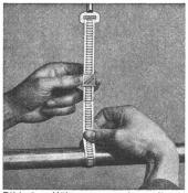
Bild 3. Höhe genau einregulieren und Zahnband eingerastet zusammendrücken
