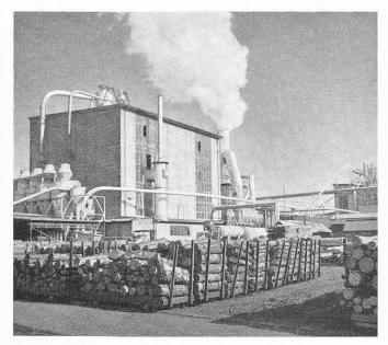
Oben: Spanplattenwerk mit Rundholzlager (Laub- und Nadelhölzer)
