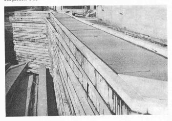
Bild 5. Geleimter Biegeträger mit Kastenquerschnitt, Stegen und Aussteifungen aus phenolharzgebundenen Holzspanplatten und lamellierten Holzgurten. Schnitt A-A: Stegplattenstoss und Aussteifung mit Spanplatten.
