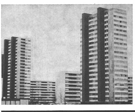
Im modernen Hochbau sind bei der Herstellung der verwendeten Wandelemente Maßtoleranzen meist unvermeidlich. Hinzu kommen weitere Verformungen durch Transport und Installation. Diese Abweichungen müssen von einem Dichtungsmaterial ausgeglichen werden. Außerdem muß dieses Dichtungsmaterial die Eigenbewegungen der Fassadenwand – verursacht durch Temperaturwechsel und Winddruck – auffangen.
