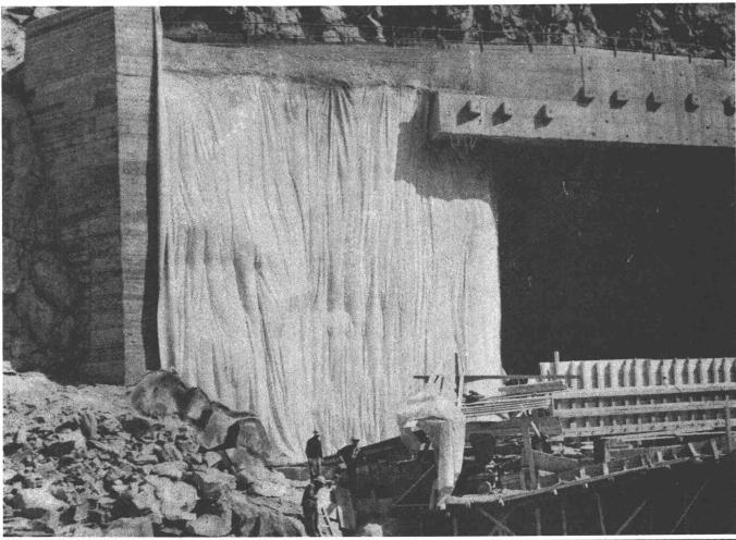
Grossflächenabdichtung System IRONFLEX Etanchement de grandes surfaces système IRONFLEX Einsatzgebiete: Staubecken und -mauern, Fundamente, Baugruben, Brücken, Schwimmbecken usw. Material: Schwerfolien verschiedener Struktur, dem jeweiligen Einsatzzweck angepasst.
