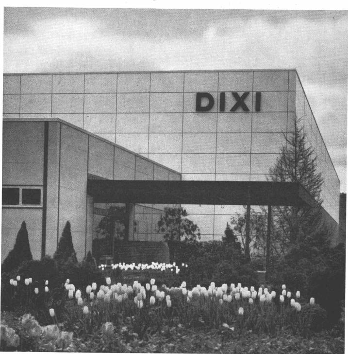
Eingangspartie der Montagehalle der DIXI SA, Le Locle; mit Empfangsräumen und Büro. Die Fassaden sind mit Asbestzement-Platten weißgranit verkleidet, sichtbar geschraubt. Architekt: W. Wurmet, SIA / EPF, Le Locle / Colombier.
