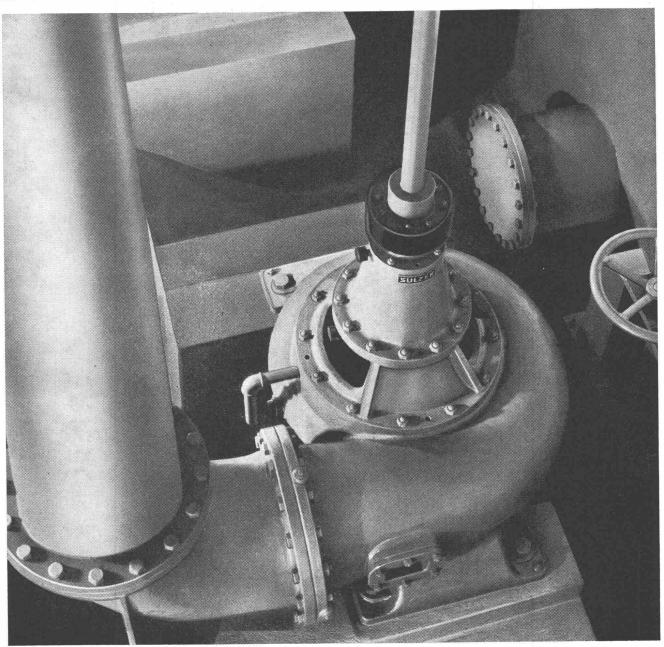
Vertikale Sulzer-Abwasserpumpe in der Kläranlage Küsnacht/Erlenbach. Förderleistung 300 I/s
