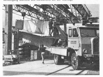
25 kreuzförmige Mittelstützen. Breite 241,5 cm, Höhe 294 cm, Länge 1684,5 cm. Stegstärken 6 und 8 cm. Elementgewicht 16 t.
