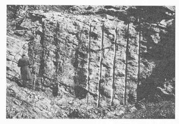
Bild 4. Abgeschossene Wand. Je fünf Bohrlöcher  $\phi$  35 mm und 105 mm, alle gleich geladen, jedoch Hohlräume zwischen den Patronen in den kleinen Löchern mit Bohrmehl ausgefüllt
