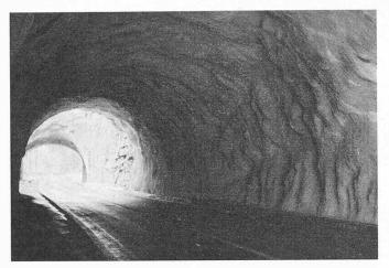
Bild 9. Tunnel an der Axenstrasse mit Gunit-Verkleidung
