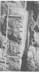
Bild 6. Im grossen Bohrloch hat das Luftpolster den Fels geschont. Die durch den Doppelmeter bezeichneten Sprengstellen waren einzig an Rauchspuren zu erkennen
