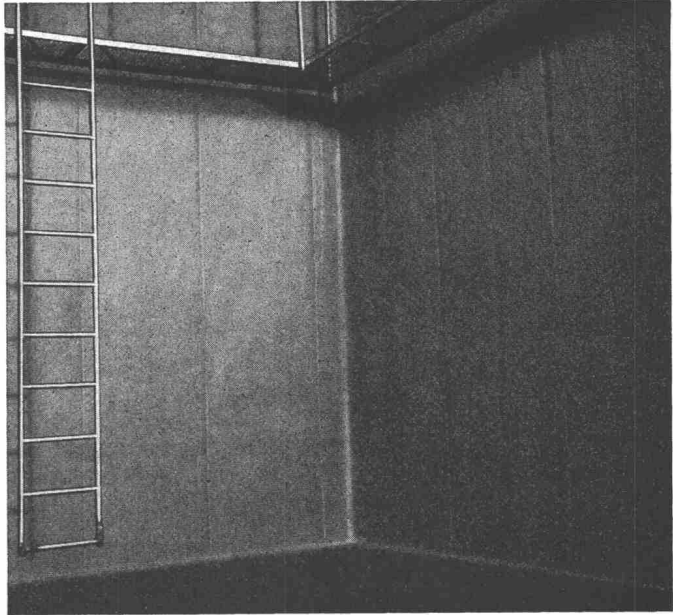
Innenauskleidung eines 250 000 l Betontanks Revêtement intérieur d'une citerne en béton de 250 000 l
