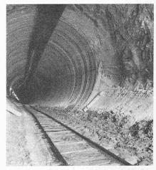
Bild 12. Im Vordergrund ausgebrochener, im Hintergrund gebohrter Tunnelabschnitt
