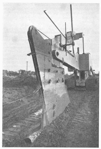
Bild 1. Automatische Rohrverlegungsmaschine «Badger Major»
