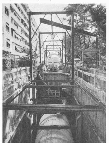
plituden von bis zu 10 cm je nach Bodenverhältnissen. Den jeweiligen Radien der Wellenform entsprechend entstehen sehr grosse örtliche Beanspruchungen des Betons, wobei diese während des Stossvorganges periodisch von einer Seite des Rohres zur anderen verlagert werden. Aus diesen Gründen verwendet man heute fast ausschliesslich qualitativ hochstehende, im Fabrikbetrieb vorfabrizierte Rohre mit abnormal grosser Wandstärke und Armierung.
