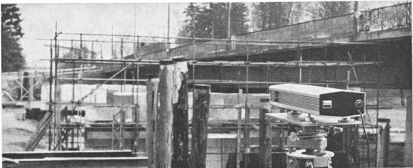
Siemens-Gas-Laser als optische Messhilfe auf einem Bauplatz
