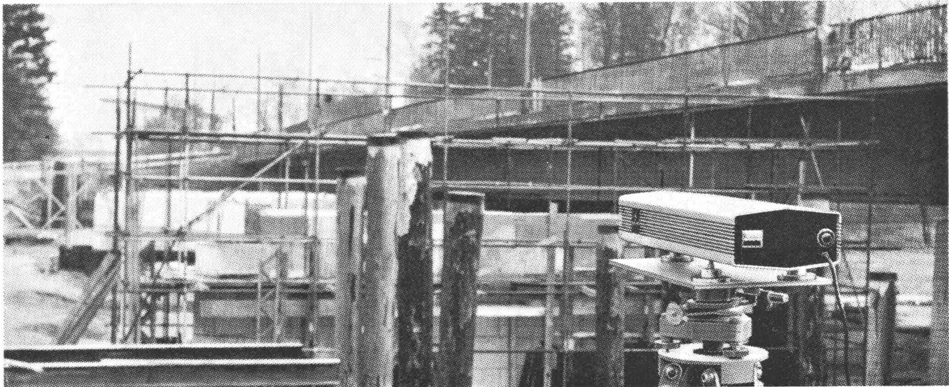
Siemens-Gas-Laser als optische Messhilfe auf einem Bauplatz
