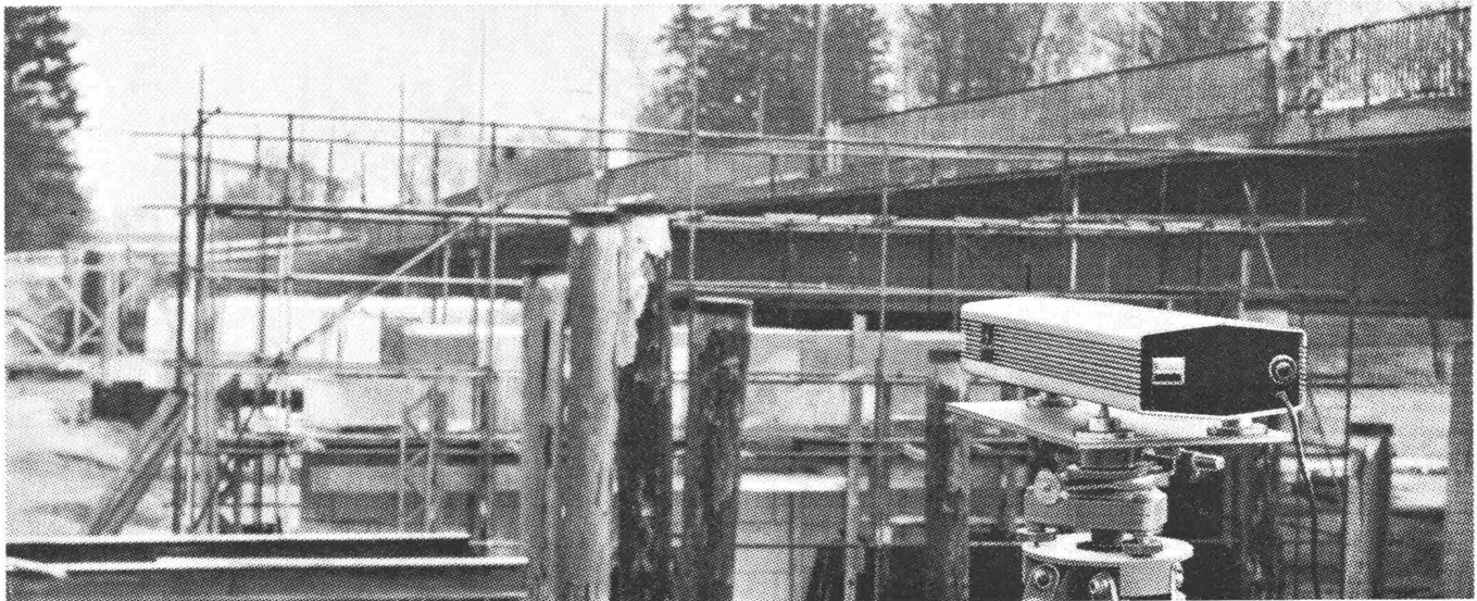
Siemens-Gas-Laser als optische Messhilfe auf einem Bauplatz
