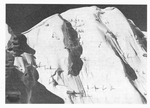
Bild 1. Stützverbauungen mit Schneenetzen im obersten Teil der Lawinenanrissgebiete am Geissberg, 2375 m ü. M. (Gurtnellen). Die steilsten Gipfelaufschwünge mit einer Hangneigung von über  $45 \div 50$ ° sind nicht verbaut und bilden das Anrissgebiet eines Schneebrettes mit seitlicher Ausbreitung in die verbauten Zonen. Unten links eine keilartig hinterfüllte Schneebrücke. Aufnahme 29. 1. 68 von W. Schwarz
