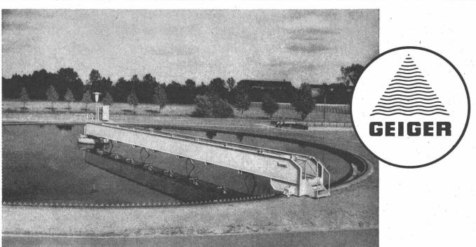
MASCHINELLE EINRICHTUNGEN **UND ARMATUREN** FÜR KLÄRANLAGEN Geiger-Rundschlammräumer haben sich für die wirksame Reinigung kreisflächiger einstöckiger Absetzbecken während des Betriebs von Sink- und Schwimmschlamm seit Jahrzehnten für Becken bis zu 78 m Durchmesser bewährt ■ Die Abbildung zeigt einen Schlammräumer für ein Nachklärbecken mit Geiger-Antrieb DBP.
