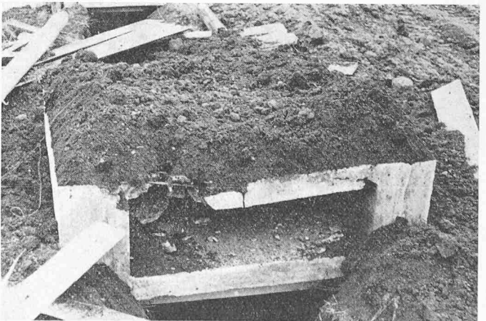
Platte 3 nach der Sprengung
