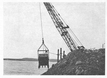
Bild 6. N 5, Bielerseestrasse. Das Material wird mit Klappschiff antransportiert und vom Bagger aus dem Wasser gehoben. In Bildmitte drei Schutzrohre für die Einführung der Flügelsonde
