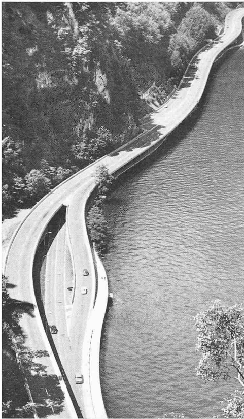
Lehnenviadukt und Tunnel der Nationalstrasse N2 Hergiswil—Stansstad am Vierwaldstättersee. Die Lokalstrasse liegt unter der Autobahn. Länge des Lehnenviaduktes 1200 m, Plattenbreite 17,20 m für beide Fahrbahnen. Variable Auskragungen seeseits über die Stützen bis maximal 9 m. Photo A. Odermatt, Stans
