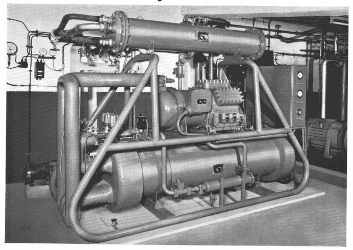
Liquifrigor®-Flüssigkeits-Kältesatz bei der Firma Kautex, Hangelar (Deutschland), zur Kühlung von 27 m³/h wässrige Alkohollösung von +5° auf +1°C (108 000 kcal/h) im Zusammenhang mit der Kunststoffherstellung. Solche standardisierte Gruppen können für die Kühlung verschiedenster Flüssigkeiten verwendet werden.
