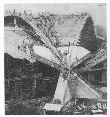
Bild 14. Gewölbe im Bau
