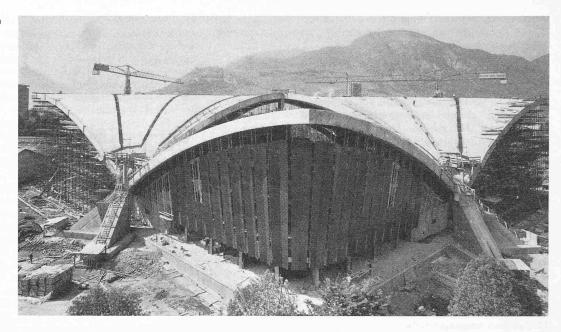
an den grossen gewährt einen sehr erwünschten Lichteinfall, ohne dass Sonnenstrahlen auf die Piste fallen können. Wie auf Bild 16 ersichtlich, bildet jedes der beiden kleineren Gewölbe im Grundriss ein Quadrat von rd. 44 m Seitenlänge. Jedes ruht auf zwei Stützen auf und ist mit dem grossen Gewölbe durch je eine Strebe 7 aus Eisenbeton verbunden. Die Unterseiten der äusseren Schalen sind mit einer Wärmeisolierung versehen.
