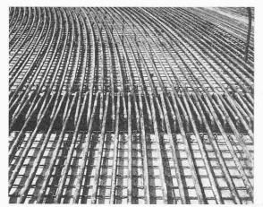
Bild 7. Berohrung des Schnellaufringes: Einzelheit in der Nähe einer Speisestelle
