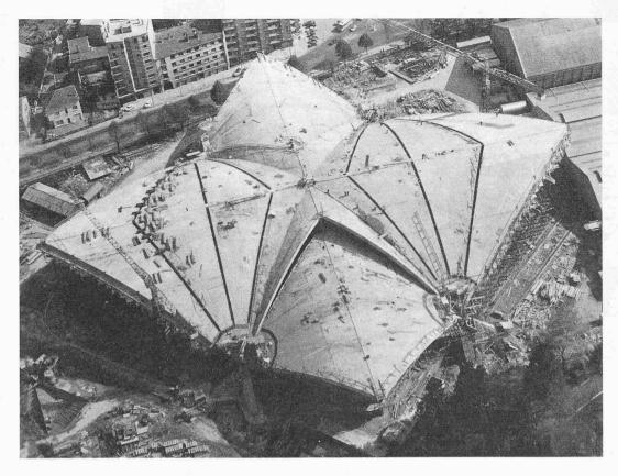
Bild 17. Blick von oben auf die im Bau befindlichen Gewölbe der grossen Eishalle
