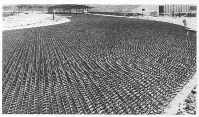
Bild 8. Armierung des Schnellaufringes, darunter die in Längsrichtung verlaufenden Kühlrohre
