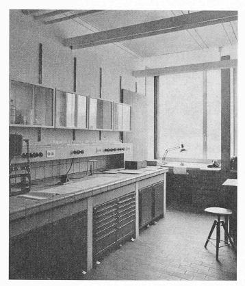
Bild 5. «Normal-Laboratorium» mit Installationswand samt auswechselbaren Rollkorpussen
