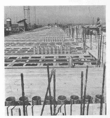
Bild 20. Baustelle Festkörperphysik mit Futterrohren für Sanitärtrassee
