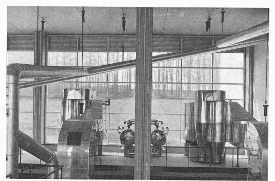
Bild 32. Energiezentrale. (Staubabscheider der Kesselanlage)
