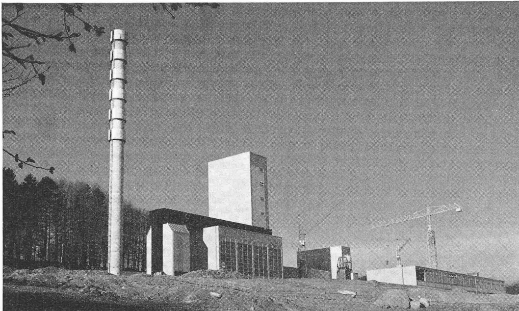
Bild 28. Energiezentrale. Gesamtansicht (ohne Rückkühlwerk) aus Osten
