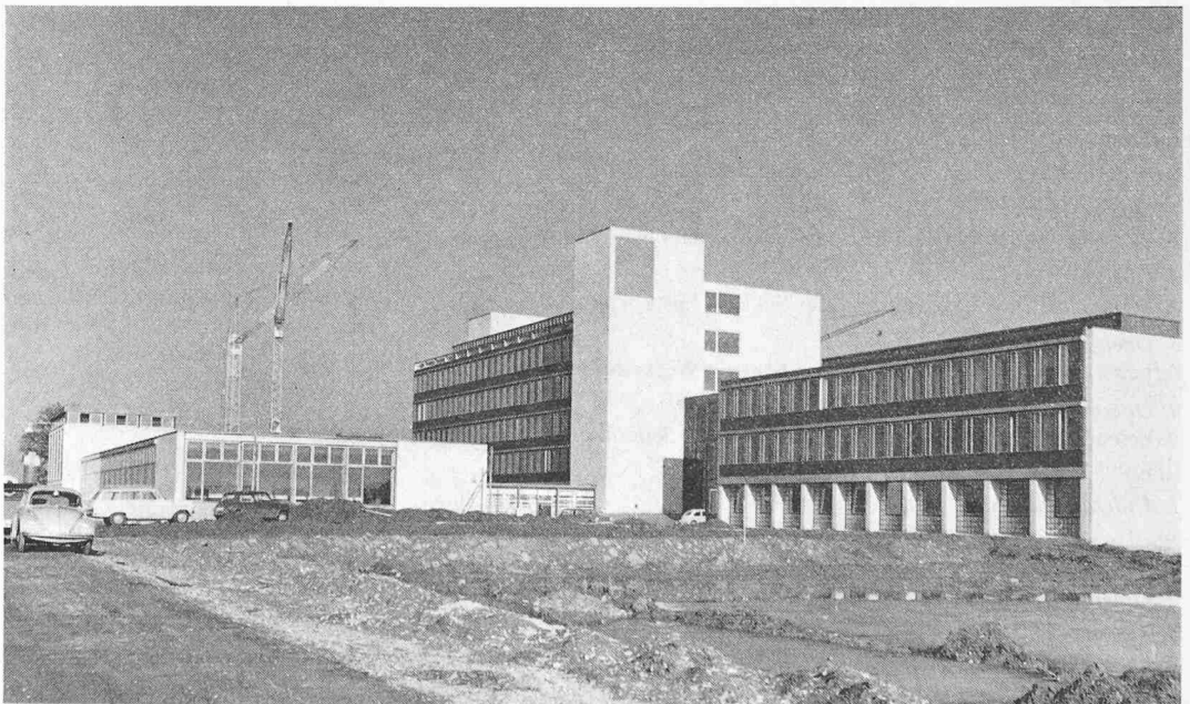
Bild 17. Südwestansicht Technische Physik und AFIF-Gebäude mit vorgelagertem Trakt Hilfsbetriebe («nichtstapelbare» Räume). Hinten Montagehalle
