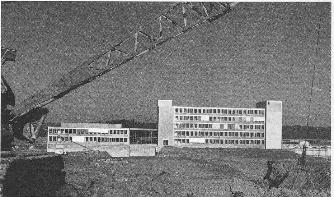
Bild 16. Ostansicht Technische Physik (links) und AFIF (rechts)
