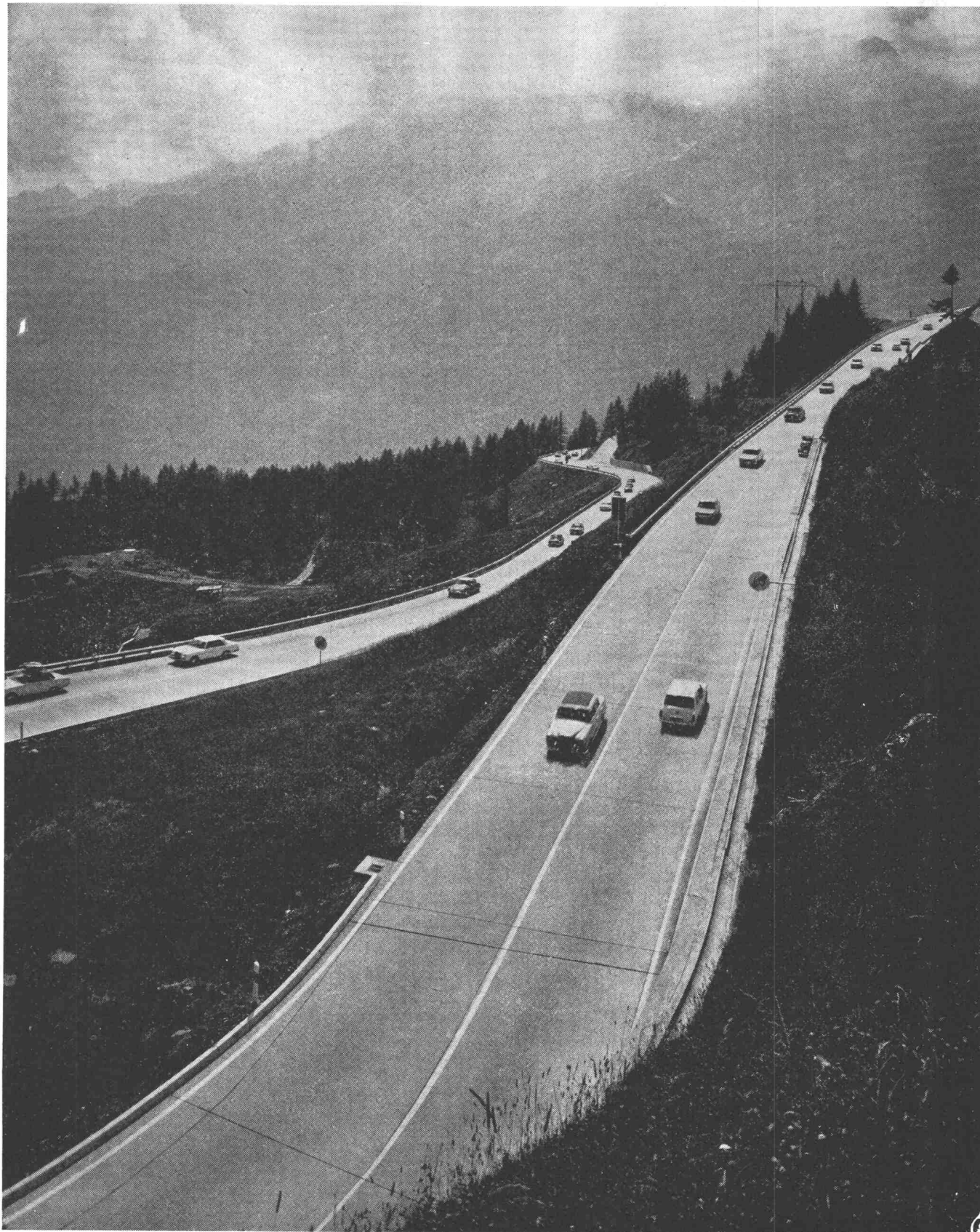
Nationalstrasse N 2 Gotthard-Südrampe, Betonbelag
