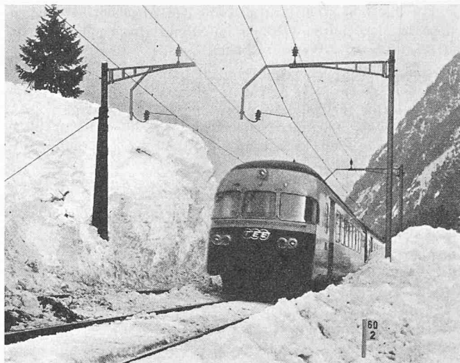
Bild 1a. Entschigtal—Lau; Gleis Wassen—Gurtellen verschüttet
