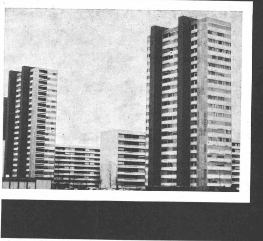
Im modernen Hochbau sind bei der Herstellung der verwendeten Wandelemente Maßtoleranzen meist unvermeidlich. Hinzu kommen weitere Verformungen durch Transport und Installation. Diese Abweichungen müssen von einem Dichtungsmaterial ausgeglichen werden. Außerdem muß dieses Dichtungsmaterial die Eigenbewegungen der Fassadenwand — verursacht durch Temperaturwechsel und Winddruck — auffangen.
