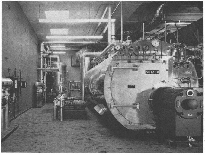
Heißwasseranlage in einer Färberei mit Sulzer-Dreizugkessel
