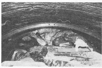
Bild 11. Im engen Bereich zwischen Fels und Maschine mussten in mühsamer Handarbeit, teilweise in Rückenlage, die Stahlbogen montiert werden. Zwei damit beschäftigte Männer sind sichtbar. Trotz diesen Erschwernissen wurden selbst im stark gebrächen Gebirge Vortriebsleistungen von 6 bis 15 m erreicht (Photos B. Petermann)
