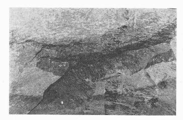
Bild 10. Blick in den Stollenfirst. Trotz des schonenden Ausbruches mit der Tunnelbohrmaschine (sichtbar an den gewölbten Strichen) wachsen in der Zugzone über dem First, besonders bei der flachen Schichtlage der Gesteine, Risse in den Berg hinein, welche häufig zu überraschenden Niederbrüchen führen. Dies tritt im übrigen bei konventioneller Bauweise noch bedeutend stärker in Erscheinung
