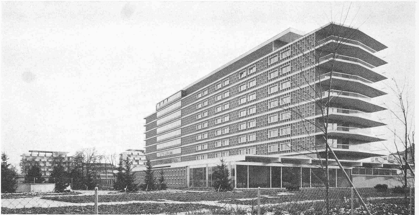
Nordostseite. In der vorderen Ecke des Erdgeschosses Speisesaal mit Cafeteria
