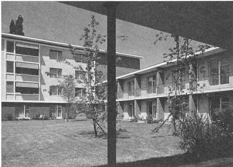
Bild 1. Alterssiedlung Luzernerring 1957. F. Vischer & G. Weber, Architekten BSA/SIA, Basel
