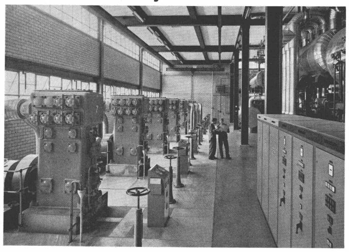
Kälteanlage mit ölfreiem Kreislauf in einem chemischen Produktionsbetrieb, mit 4 einstufigen und 3 zweistufigen Labyrinthkolben-Kompressoren, zur Verflüssigung eines Prozess-Stromes mit 765 000 kcal/h bei –46 °C und zur gleichzeitigen Kühlung von Sole mit 1400 000 kcal/h bei –18 °C.
