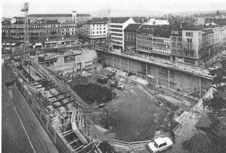
Bild 5. Allgemeiner Aushub auf rund 10 m. Beginn des Kernaushubes. Auffahrtsrampe links im Bild. Beide Ankerreihen ausgeführt
