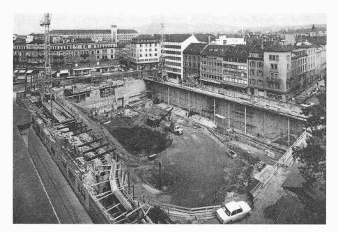
blieben unbeschädigt. Die verwendeten Anker von ø 26 mm waren üblicherweise auf 30 t vorgespannt. Es folgt daraus, dass die Anker innerhalb der Isolationszone, vor Anbringen derselben entweder entspannt oder, wenn dies nicht möglich ist, mit einer Kopfplatte versehen werden müssen.
