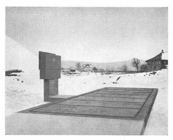
Brücke 10×2,8 m, Laufgewichtsbalken mit parallelgeschaltetem Messkopf
