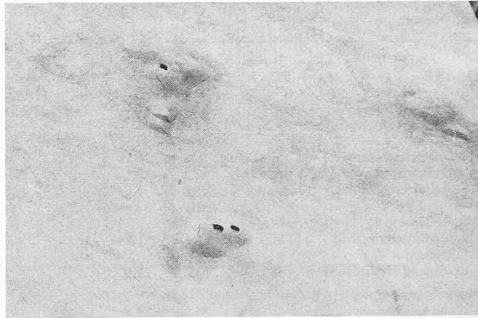
Bild 8. Blasenbildung an der Fassade eines neuen Miethauses im Tessin, an welcher der Deckputz mit ungenügend gelöschtem, dolomitischem «Weisskalk» hergestellt wurde. Die Blasen entstanden etwa drei Jahre nach dem Verputzen, sie vermehren und vergrössern sich zusehends. Der ganze Putz muss erneuert werden, diesmal hoffentlich mit normengerechtem, echtem Weisskalk
