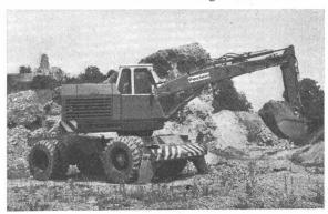
Die wichtigsten technischen Daten des Typs TY 2 P: luftgekühlter 4-Zylinder-Deutz-Dieselmotor 48 PS, Fahrgeschwindig keit bis 12 km/h (5 Vorwärts- und 5 Rückwärtsgänge), äusserer Wenderadius 7,2 m, Steigfähigkeit 60 Prozent, Gewicht mit einer Ausrüstung rund 10,3 to, Ausrüstungen: Tieflöffel, Greifer, Ladeschaufeln, Kranausleger, Kranhakenvorsatz, Hydraulikwinde, Güterumschlagausleger.
