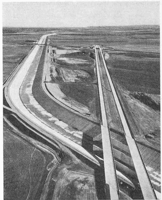
Bild 3. Das «California Aqueduct» im San Joaquin-Tal. Durchflussmenge 370 m 3 /s; Breite oben 77 m, Sohlenbreite 33,6 m; Tiefe 10 m. Das Bild zeigt die Kreuzung mit einer vierspurigen Autobahn
