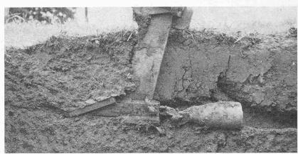
Bild 9. Maulwurfdrain, Längsschnitt (nach Feichtinger, Bundesinstitut für Kulturtechnik und Technische Bodenkunde, 3252 Petzenkirchen, Österreich)
