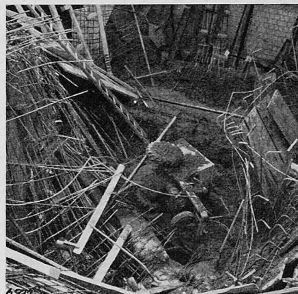
Eingestürztes Deckenfeld. In der Mitte ist der für die Betontransporte benutzte Motorkarren ersichtlich («Herkules»-Kipper)
