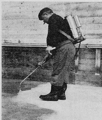
Bild 5. Aufsprühen des Decken-trennmittels
