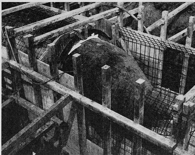
Bild 3. Eia-Gummischalung verlegt und Auftriebssicherung eingebaut. Seitenschalungen gestellt und ein Teil der Scheitelbewehrung verlegt
