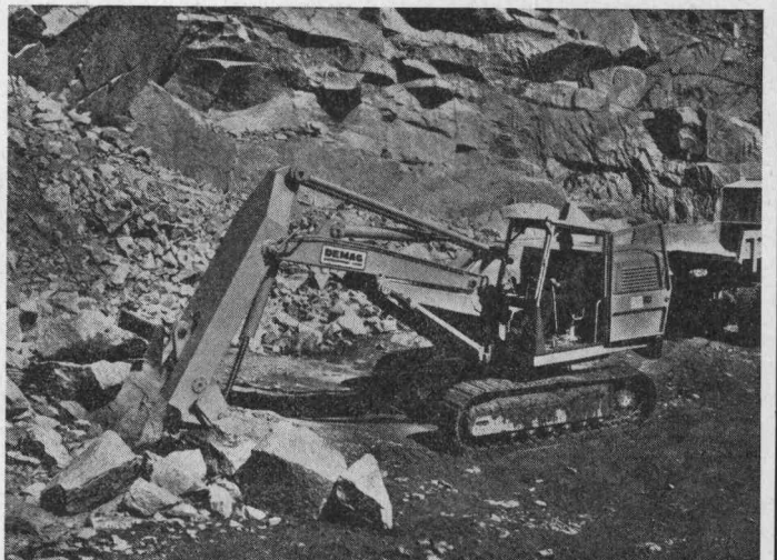
Der neue Demag-Hydraulik-Bagger
