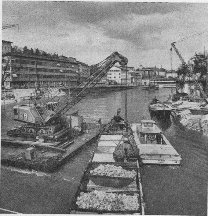
Demag-Bagger B 412 beim Ausbaggern der Rheinsohle unterhalb des neuen Kraftwerkes Schaffhausen
