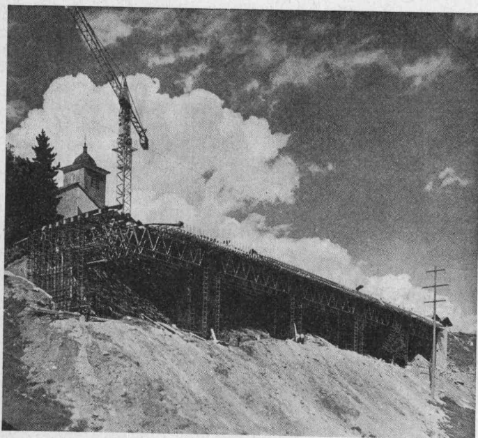
Bild 3. Brückenlehrgerüst mit den neuen Rüstträgern Raco-Innocenti Typ « S »
