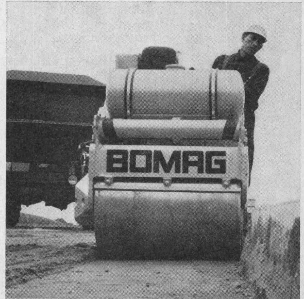
Die BW 200 fährt auf Heissmischtragschicht bis an den Fertiger
