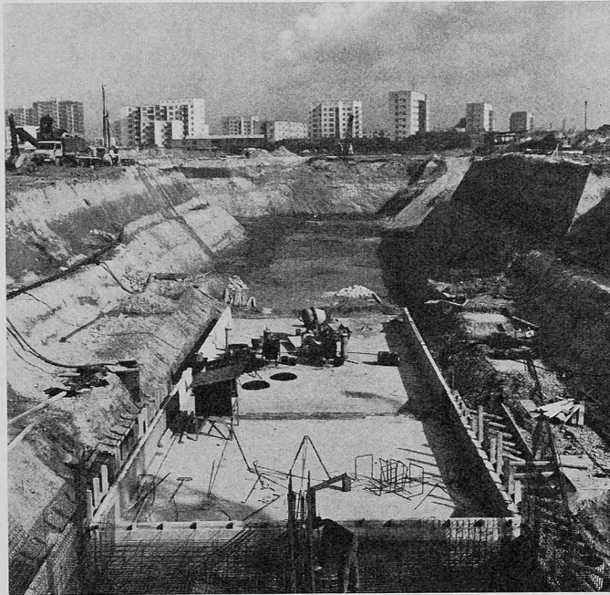
Bild 3. Tunnelbau in abgeböschter Baugrube im Frankfurter Nordweststadt-Zentrum
