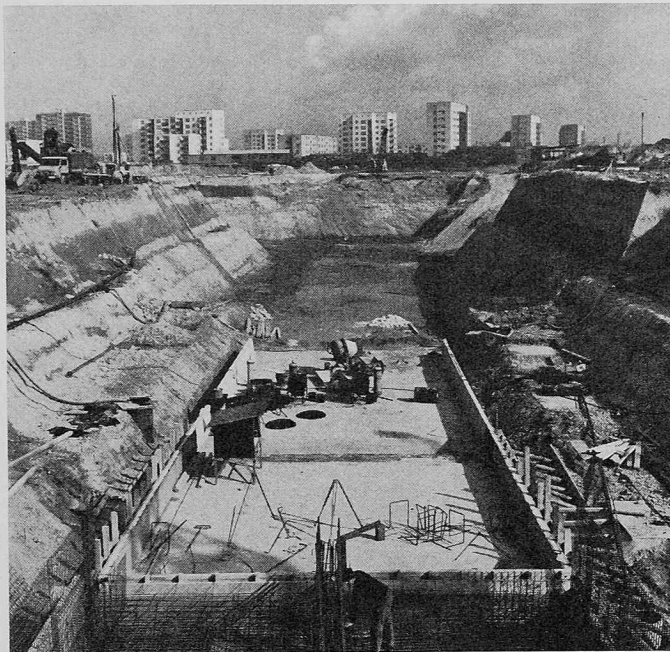
Bild 3. Tunnelbau in abgeböschter Baugrube im Frankfurter Nordweststadt-Zentrum
