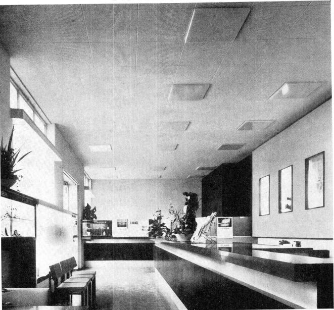
Wandverkleidungen aus Pavatex-Bauplatten 12 mm in einem modernen Reisebüro. Unterkonstruktion: Lattenrost, Lattenabstand 45 – 50 cm. Platten gestrichen.
