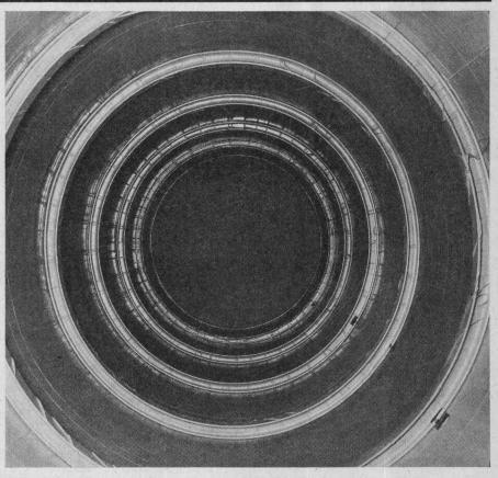
IRONFLEX-PVC-Innenauskleidung eines 100 000-I-Heizöltanks
