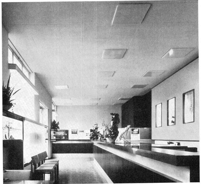
Wandverkleidungen aus Pavatex-Bauplatten 12 mm in einem modernen Reisebüro. Unterkonstruktion: Lattenrost, Lattenabstand 45 – 50 cm. Platten gestrichen.
