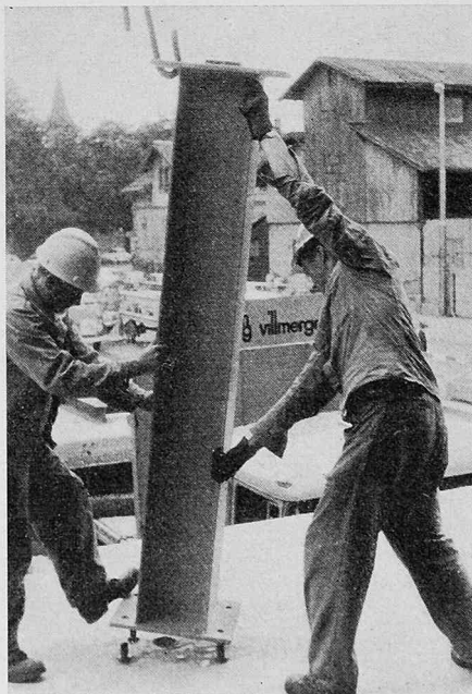
Bild 6. Absetzen der Stahlstützen auf genau horizontalisierte Stellmuttern
