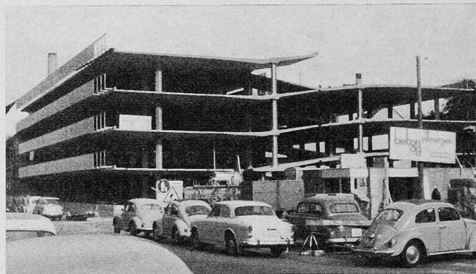
Bild 4. Ansicht des fertig montierten Parkhauses von der Stirnseite mit teilweise montiertem Geländer, Treppenhause noch nicht montiert
