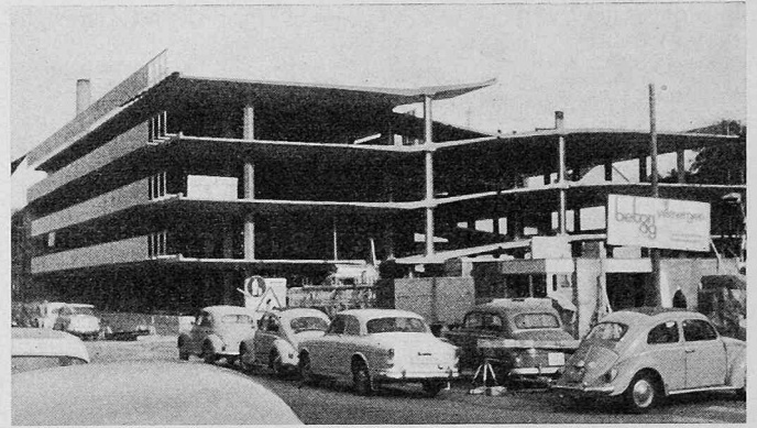
Bild 4. Ansicht des fertig montierten Parkhauses von der Stirnseite mit teilweise montiertem Gelände, Treppenhäuser noch nicht montiert
