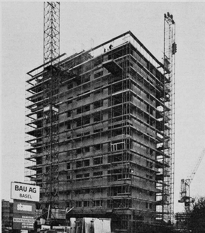
Baufaufnahme von der Friedhofstrasse gegen Hochhaus 1
