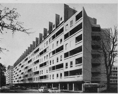
préfabriquées. Une centrale thermique générale assure le chauffage de tous les immeubles, ainsi que la distribution de l'eau chaude. Les fenêtres des appartements sont réalisées avec vitrage isolant et avec des stores roulants et réglables.
