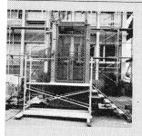
Die Bodenstation wird komplett montiert auf den Bauplatz geliefert und auf einer vorbereiteten Fundamentplatte festgeschraubt. Eine Schachtgrube ist nicht mehr nötig.
