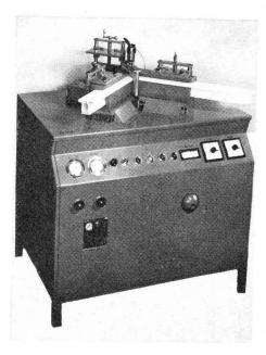
Der Automat ist aufgrund jahrelanger Erfahrung nach den neuesten Kenntnissen entwickelt worden und für das Schweissen von Kunststoff-Profilen der verschiedenen Fenstersysteme bestens geeignet, welche von Lizenznehmern aus Kreisen des Tischler- und Metallhandwerks hergestellt werden.
