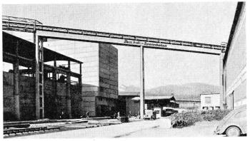
Bandbrücke aus Lecahade-Leichtbeton im Portlandzementwerk Olten
